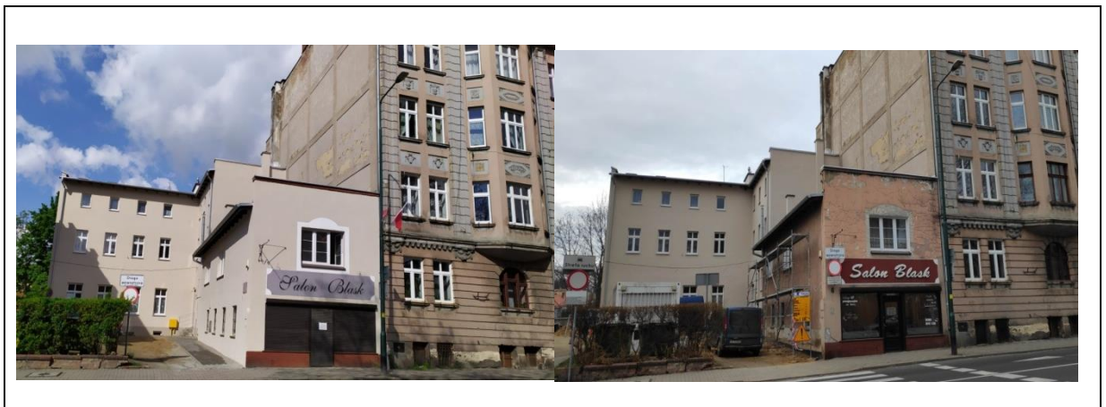
Fot. 4 Realizacja nowych nośników reklamowych – ul. Żeromskiego
